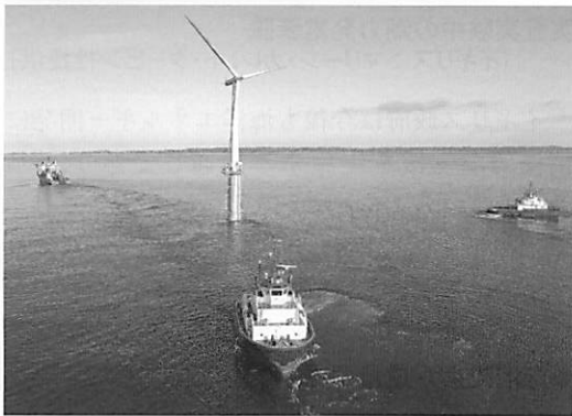
海上で行われる浮体式風力発電装置の実証実験 （ノルウェー：シーメンス社提供）
