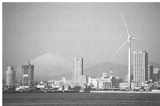
日本の各地に誕生する風力発電施設2 (神奈川県・横浜市、横浜市提供)
