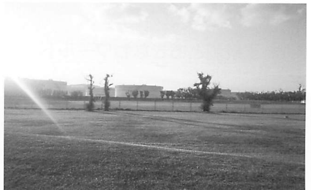
石油備蓄基地
