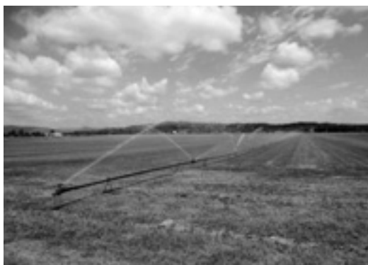
写真2 整備された灌漑施設
