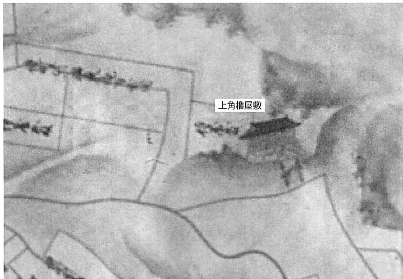
図4-2 《豊後直入郡岡城絵図》の上角櫓屋敷 内閣文庫【諸国城郭絵図】(国立公文書館蔵)から部分拡大
