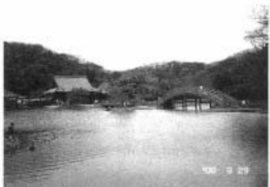
「称名寺浄土庭園」朱塗りの反橋、平橋の向こうの建物が金堂 —金堂は元和元（1681）年再建（当初は茅葺） 橋は昭和62年復元—
