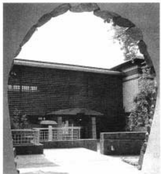
平成2年竣工神奈川県立金沢文庫正面玄関を新トンネル内より見る。右手後方に中世切通しがある。
