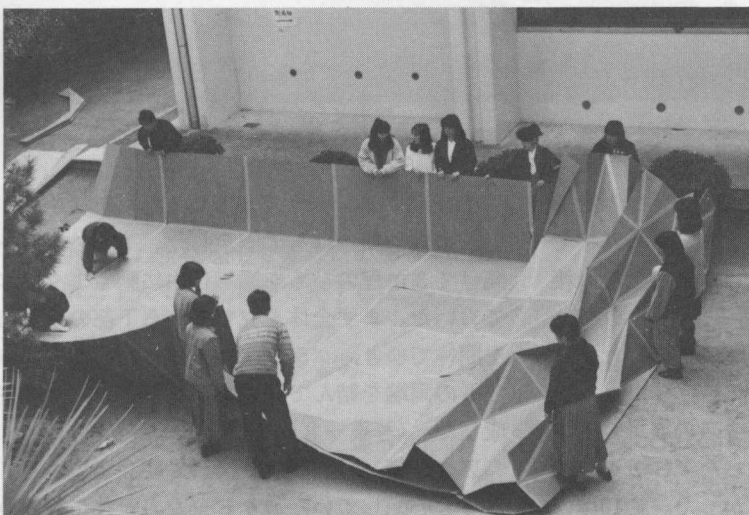
写真-5 ドームの組みたて
