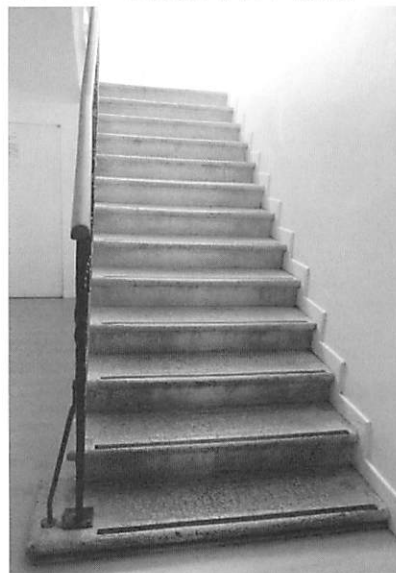
写真14 トリエステ精神保健局バルコラ精神保健センターの段差の低い階段
