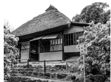
高台寺傘亭外観
