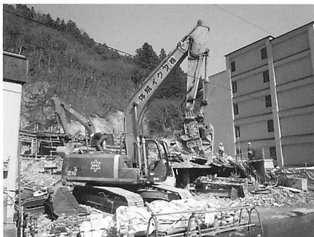
写真1 「修復不能の旅館の解体工事」
